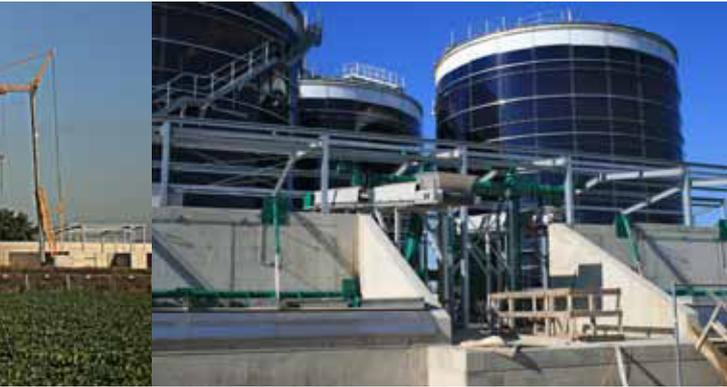
Blick auf die Eintragsbaugruppen für die Substrate, rechts und links die beiden Schubbodenbunker mit Abdeckung.
