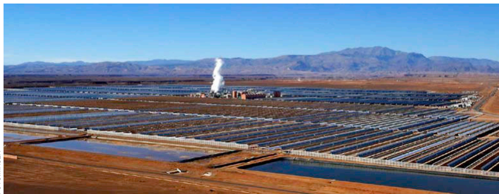
Marokkanisches Solarkraftwerk NOOR I bis IV bei Ouarzazate
