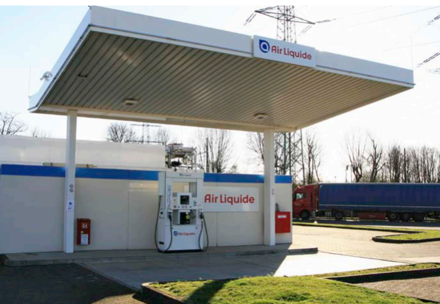
Wasserstoff ist ein Schlüsselement der zukünftigen Energiewirtschaft und wird den Bedarf an grünem Strom massiv steigern (Wasserstofftankstelle in Frechen bei Köln).
